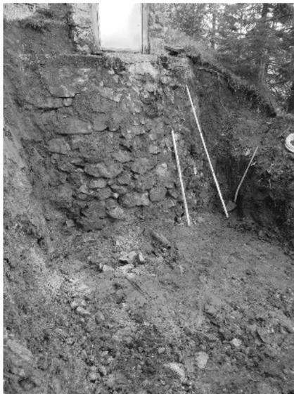
Réservoir situé sur le chemin menant au Col du Loup, construit en moellons
