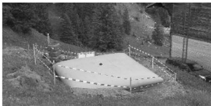
Réservoir provisoire de 30'000 litres pour ne pas interrompre l'exploitation du Chalet durant l'été
